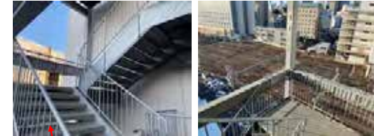
③避難外階段 1階～9階まで上がると線路上から撮影（階段を利用してください）
